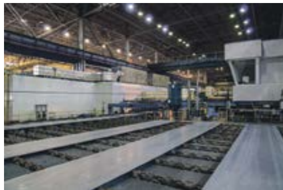
На производстве толстолистового проката Листопрокатный цех № 1
